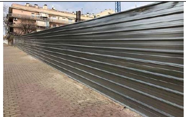
Tanca d'alçada 2 m, de planxa nervada d'acer galvanitzat, pals de tub d'acer galvanitzat.
